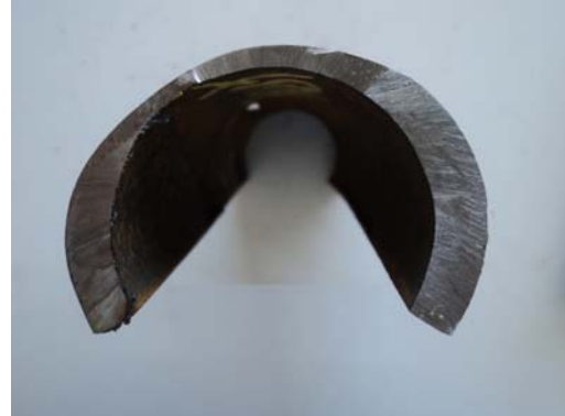
Figura 22 - Tubo desgastado por abrasão pela areia arrastada pelos gases de combustão (2)
